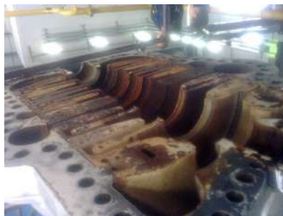
Рисунок 4.3 - Нижня частина корпусу відцентрового компресора після довгих років експлуатації
