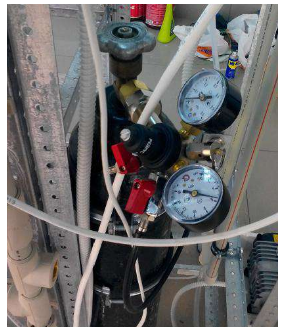
Система контролю подачі вуглекислого газу
