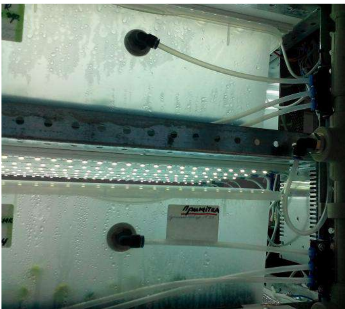
Контейнери із газопроводами
